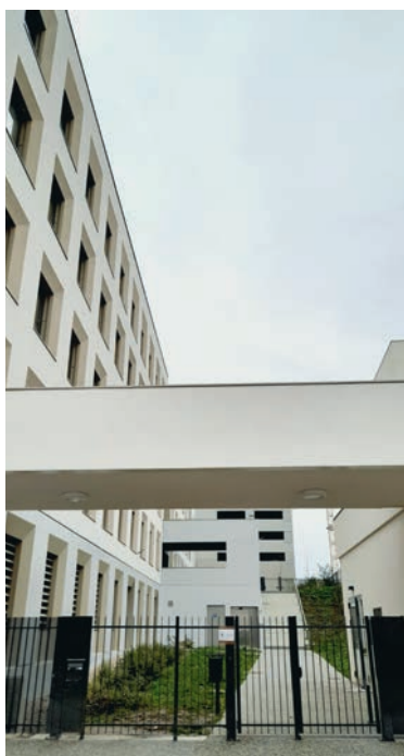
Un accès et un accueil communs pour les deux entités.
