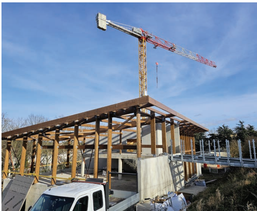
Construction de l'école Pierre-Montet
