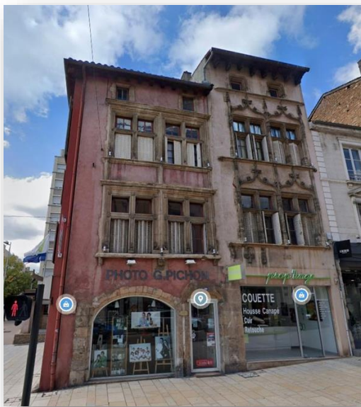
Façade rue Nationale
