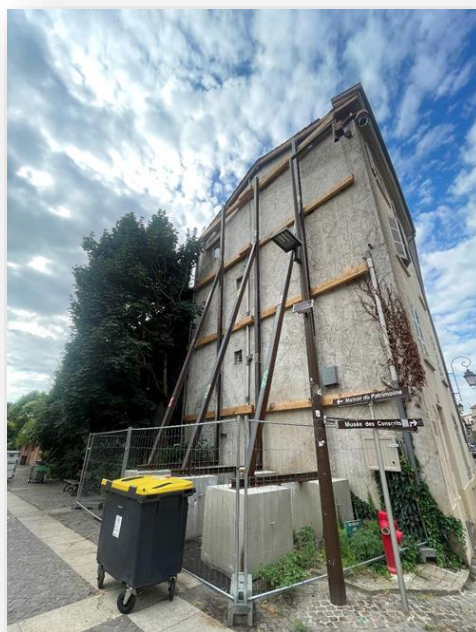
Façade depuis la Place des Marais
