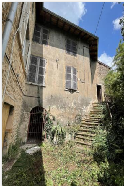
Façade depuis la cour intérieure
